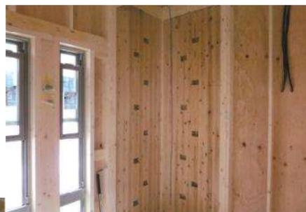
耐震補強工法「壁柱」
