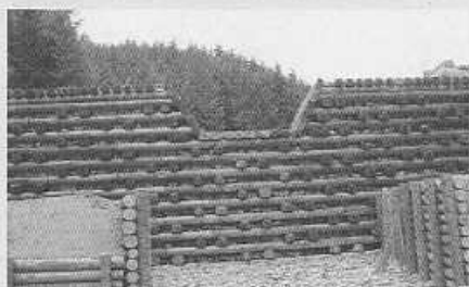
府内産木材使用の木製谷止工(高槻市杉生)
