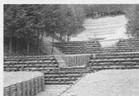
木製治山ダム
