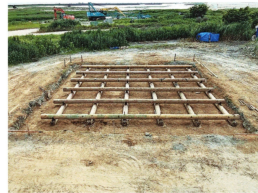
実大実証実験棟の丸太基礎
